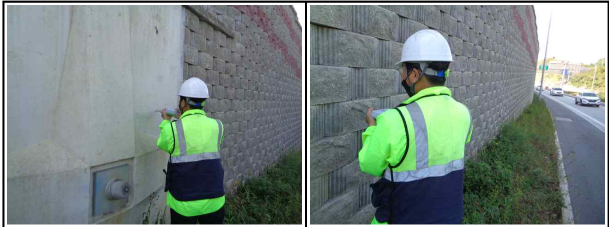
【그림 5.3.6】 슈미트해머를 이용한 반발경도시험 전경
